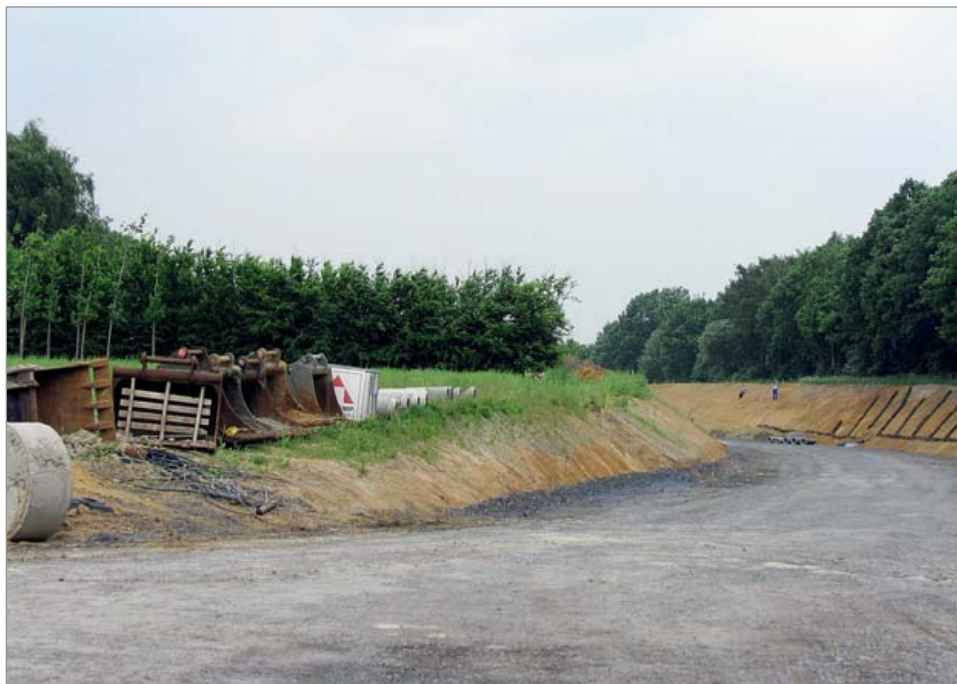
Straßenbauvorhaben stellen Eingriffe in Natur und Landschaft dar.
